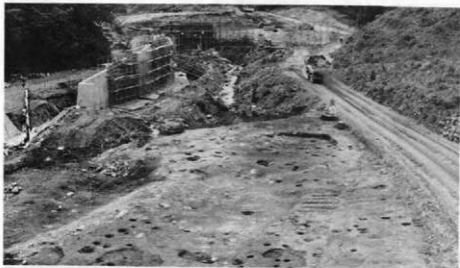
F II・III区 完掘状況
