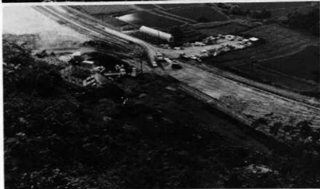
調査終了時の状況、 工事進行状況と部 材搬出（北から）
