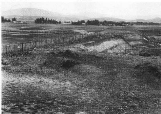
図20-1 5号現況(南西から)
