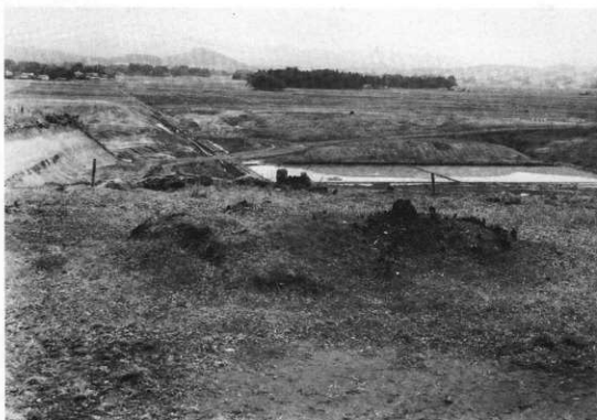
図25-1 6号現況(西から)
