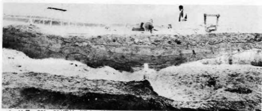
b. HⅢ-301～304溝址 (埋土の状況)
