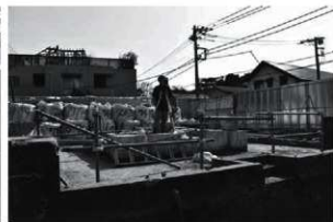
5 作業風景 (北から)
