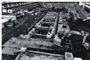
4 作業風景 (西から)
