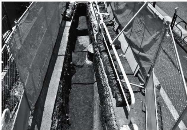
2. C区全景 (北から)
