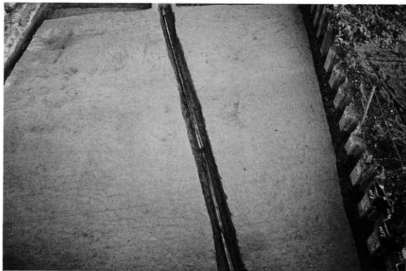
2Bトレンチ 竹筒暗渠2 全景 (西から)
