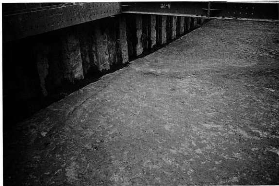
Bトレンチ 水田、畦畔 (北西から)
