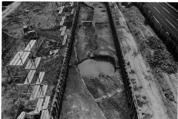
Bトレンチ 自然河川1 (北から)
