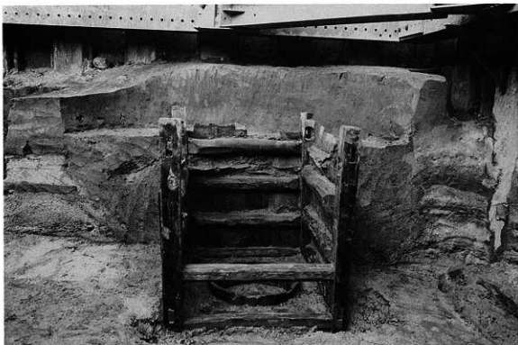
13Bトレンチ 井戸8 中段・下段木組み枠 (南から)
