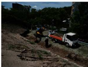
c 地点掘削状況
