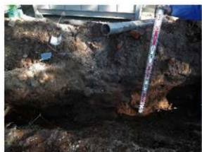
二の丸催し広場排水管改修工事 ①地点土層断面
