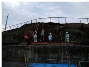
h 地点補修状況
