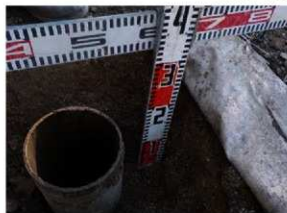
竹の丸給水蓋改修工事
