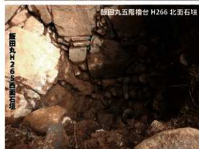
図7 飯田丸五階櫓台石垣基礎 (21/22)
