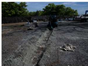
平左衛門丸掘削状況
