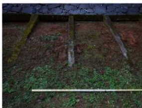
調査前近景（北から）
