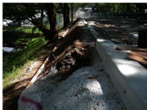
法肩工事盛土造成終了（北から）
