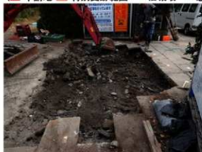
掘削状況（西から）
