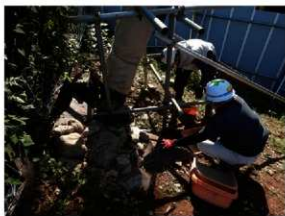
掘削作業（西から）
