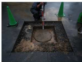
掘削状況（東から）
