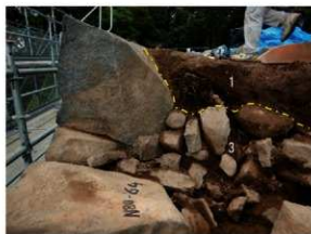
N79 解体範囲東端部 (西から)
