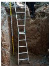
①地点 浄化槽掘削状況(東から)
