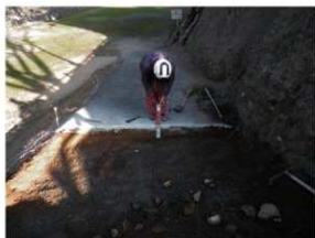
掘削状況（南から）
