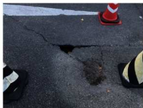
調査前（東から）
