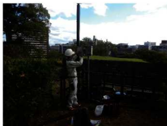
モニタリングメンテナンス作業
