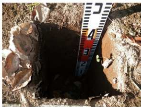
北側支柱撤去 (東から)
