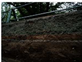
路面近景（北東から）
