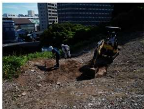
g 地点補修状況
