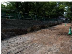
張り出し歩道部分掘削状況（南から）
