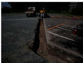
b 地点掘削状況
