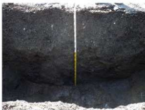
2 トレンチ土層断面（北から）
