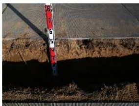
4：給水管南北方向南側 土層断面
