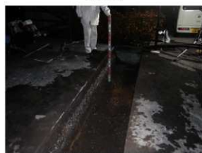
掘削状況 (西から)
