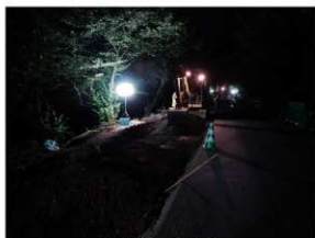
掘削状況（北から）
