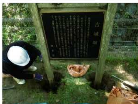
古城堀端公園 掘削状況
