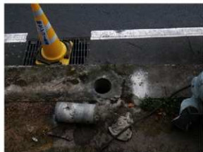
掘削状況（南から）
