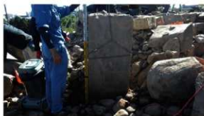
昭和28年設置のコンクリート基礎
