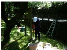
法華坂脇 掘削状況
