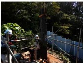
控柱回収作業（西から）
