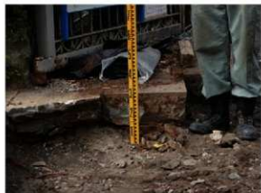
掘削状況（東から）
