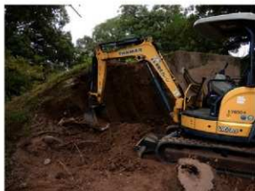
撤去作業状況（西から）
