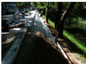
法肩工事盛土造成終了（南から）
