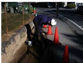
撤去作業 (南から)
