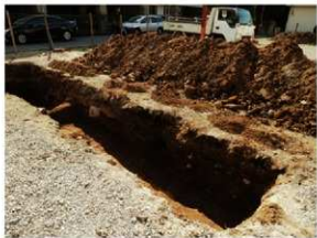
3 トレンチ全景 (北東から)
