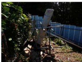
控柱養生作業後（西から）
