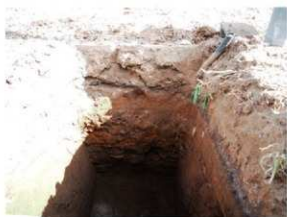
No. 5 地点土層断面 (南西から)
