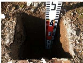
南側支柱撤去 (東から)
