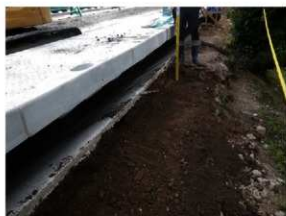
解説板再設置掘削（南から）
