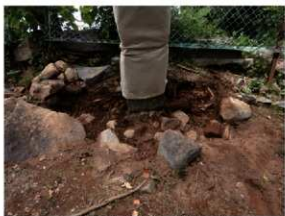
裏込め検出状況（南から）
