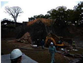
H233・H234 石垣石材回収状況
