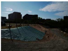
e 地点施工状況
