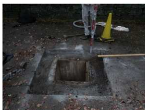
掘削状況（北から）
