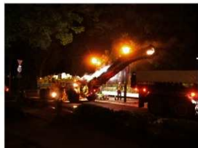
掘削状況（南から）
