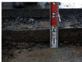
掘削断面（東から）
