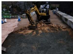
西側地点掘削状況（南から）
