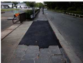
アスファルト舗装完了状況（西から）
