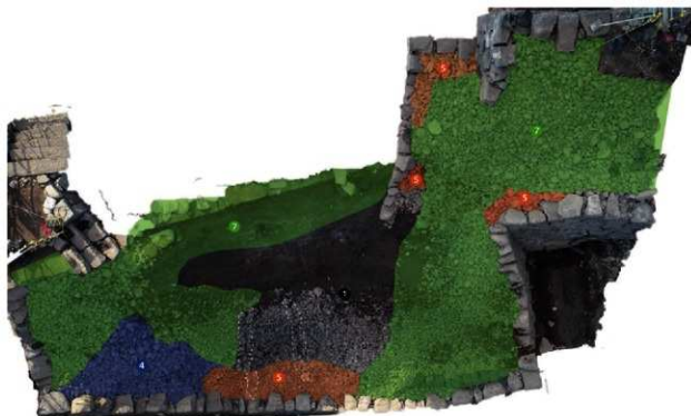
平櫓解体時平面写真 (18段目解体前) ※写真上が南
