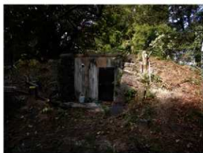
撤去前現況（東から）
