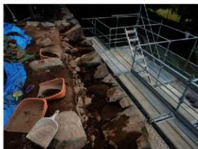
N79 解体範囲 (北から)
