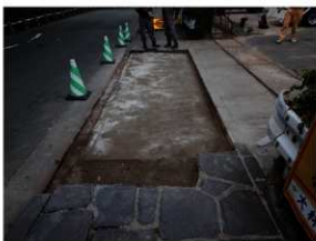
掘削完了状況（東から）
