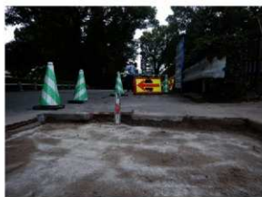
工事箇所土層断面（東から）
