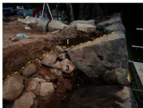
N79 解体範囲南端部 (北から)
