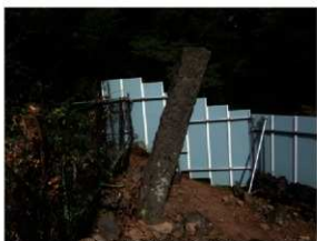
控柱養生作業前（西から）
