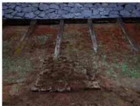
埋め戻し完了状況（北から）
