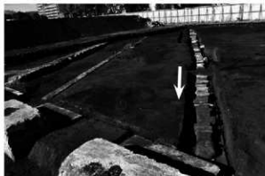
6 18号倉庫北側前面排水路(矢印:水流方向)(東)
