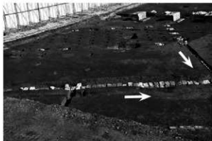
5 18号倉庫北側前面排水路(奥:1・2号建物跡)(南)
