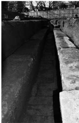
6 18号倉庫北側前面排水路 底面煉瓦敷(東)
