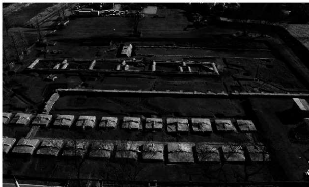
7 引き込み線・貯水タンク (北)
