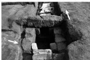
8 18号倉庫北側前面排水路 枝管結合部研(西)
