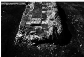
4 20号倉庫基礎 関東大震災後の補強 (右側鉄筋コンクリート)
