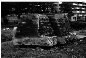
4 5号倉庫基礎レンガ保存用切り出し
