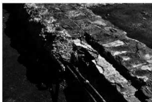
6 20号倉庫基礎 関東大震災後の補強
