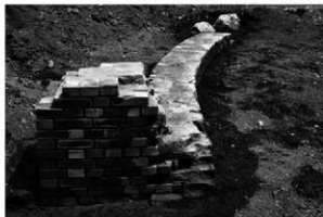
8 第三貯水池基礎（北）
