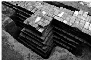
6 9号倉庫 地中基礎レンガ (南)
