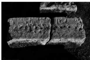
1 排水路石蓋接合状況
