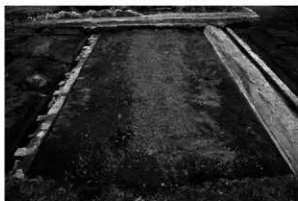
3 引き込み線砂利敷 (西)
