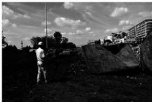
7 貯蔵タンク (解体取り上げ後)
