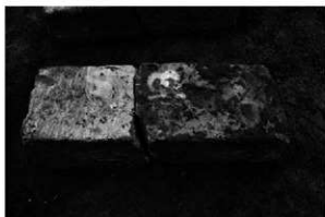
3 排水路石蓋接合状況
