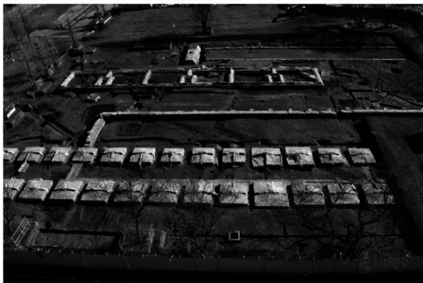
2 5号倉庫（羊毛倉庫）（北）
