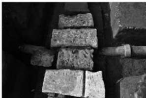
8 排水路 本管と枝管
