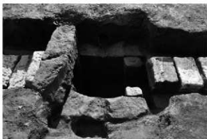
2 18号倉庫北側前面排水路 枝管設置場所(北)
