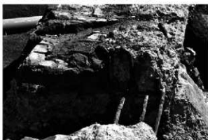
7 20号倉庫基礎 関東大震災後の補強
