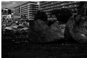
6 貯蔵タンク (解体取り上げ後)
