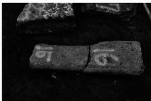
4 排水路石蓋接合状況
