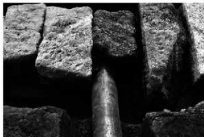
7 排水路枝管 本管への連結部
