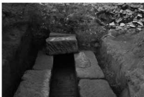
4 18号倉庫北側前面排水路 西端部石蓋設置状況(東)
