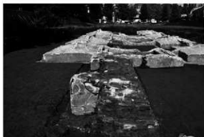
1 5号倉庫基礎レンガ(東)
