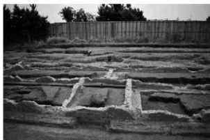
3 4A 区旧 38 号棟 基礎内③ (北)
