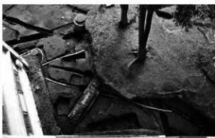
2 2B・2C区全景 (43号棟から) (東)
