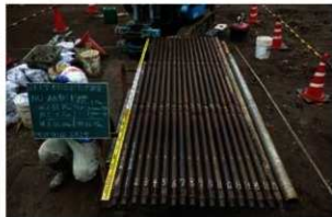
5 1区 ボーリング調査 (2020.7.31)
