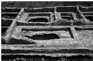
6 4B 区旧 35 号棟 基礎内⑧ (西)
