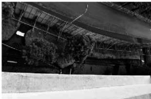
6 2B区東側 全景 (43号棟から) (西)
