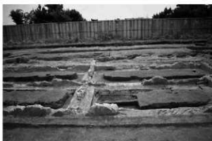
2 4A 区旧 38 号棟 基礎内② (北)
