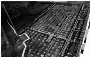
3 2A区 全景 西寄 (504号室から) (北)
