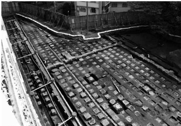
2 2A区 全景 (41号棟から)(北)
