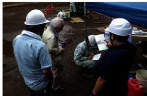
7 1区 ボーリング調査 (2020.7.27)
