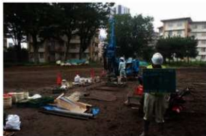
4 1区 ボーリング調査 (2020.7.31)
