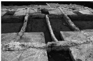
6 4B 区旧 33 号棟 基礎内② (南)
