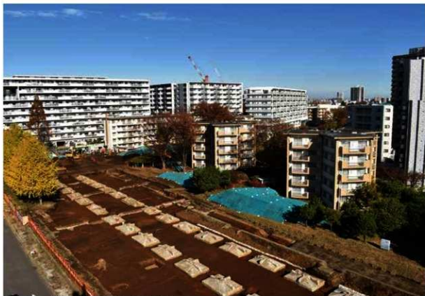
1 ドローン撮影による1区遠景 (2019.12.5)
