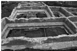
7 4B区旧35号棟 基礎内① 5号倉庫基礎(西)
