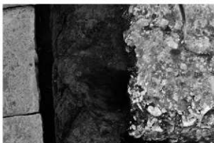
4 288号住居跡P1南北土層断面 (東)
