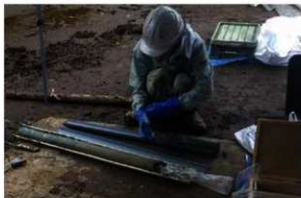
6 1区 ボーリング調査 (2020.7.27)
