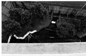
5 2B区東側 全景 (43号棟から) (西)
