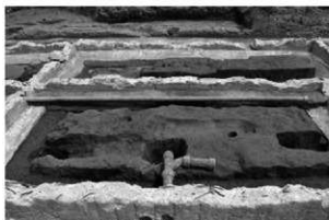
3 4A区旧38号棟 基礎内⑪(北)
