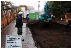
5. 表土剥ぎ (北東)
