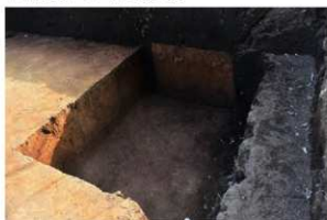
5. 旧石器トレンチ6全景 (北西)
