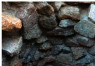
10区 SE05 石組細部 (北より)
