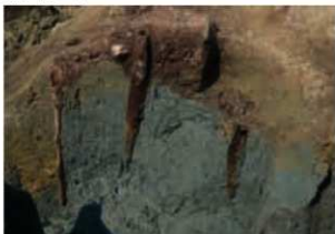
6区 SG03 護岸木杭 (南より)
