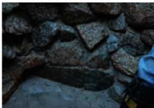
10区 SE05 石組細部 (北より)
