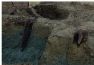
6区 SG03 護岸木杭 (南より)
