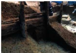
6区 SD215 東側護岸施設細部 (西より)
