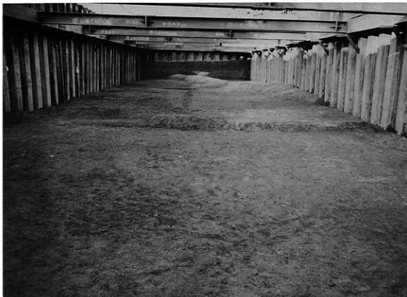
Bトレンチ 水田 (南から)
