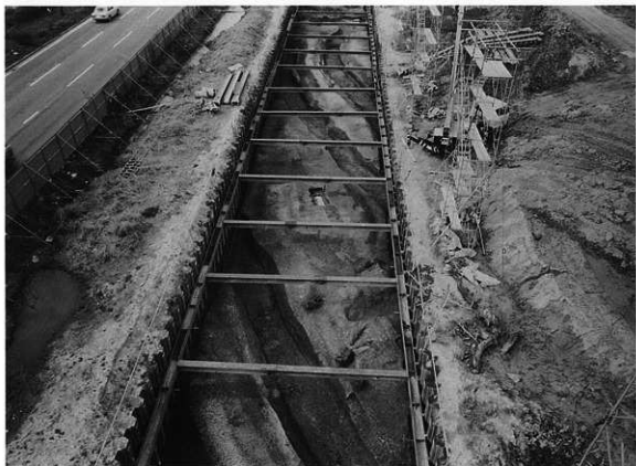
Bトレンチ 環濠状遺構 (南から)
