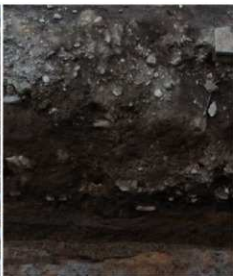
土壘断面詳細 (東から)
