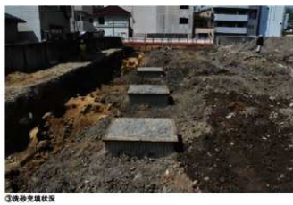
図6 鉄枠と洗砂による石垣の保存
