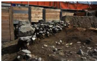
石垣断面a (西から)
