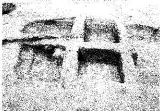
主体部ベルト設定状況（東より）
