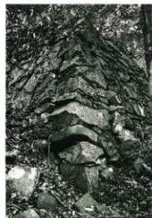
北西隅角部の状況
