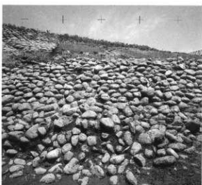
旧堤防 (断面の状況。西から東へ連続撮影①→④) 旧堤防 (現堤防と旧堤防交差部の状況。南から北へ連続撮影⑤→⑥)
