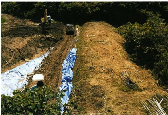
現堤防馬踏（北より。奥は上岡山）
