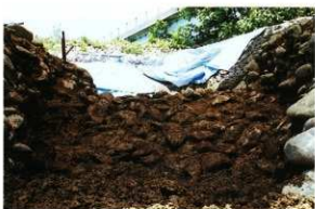
断面調査の状況2
