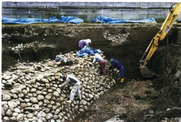
旧堤防出土状況と作業風景2
