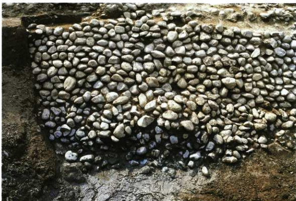
旧堤防南側 裏法下部分
