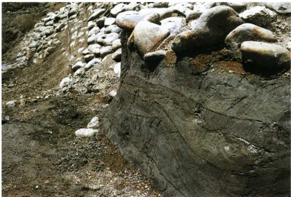
旧堤防 A. 南側崩落部分と堆積層
