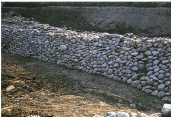
堤防遺構検出状況
