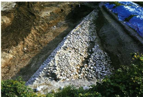
旧堤防全景（北より）
