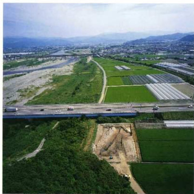
現堤防・石組遺構・旧堤防遠景（南上空より）
