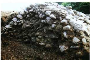
断面調査 (南面)
