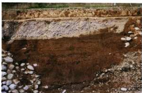
調査区北 北壁 旧堤防裏法より東側
