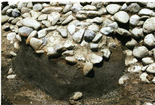
旧堤防 A. 南側崩落部分（東より）
