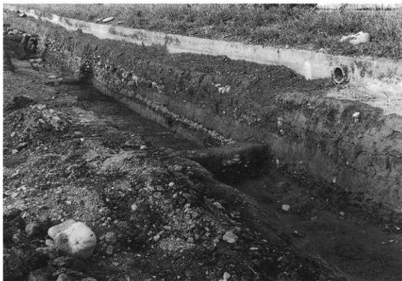
G区SR 完掘状况 (北侧)
