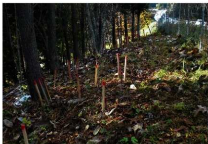
ボーリング調査実施状況
