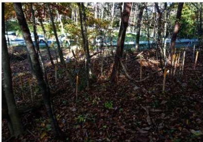
ボーリング調査状況
