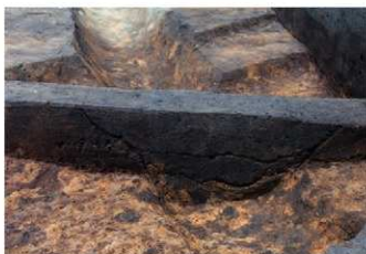
4. 30号溝土層断面D-D' (東から)
