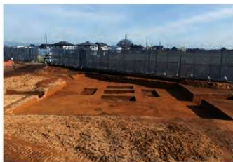
1. 1区旧石器14号トレンチ拡張部(西から)
