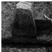
C-C'セクション①(北から)
