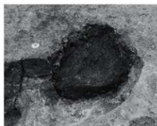
13. 1号柵P5断面(南東から)
