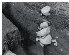
14. 1号石垣断面(南西から)
