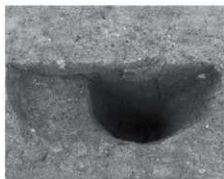
11. 4号柵P5断面(南東から)
