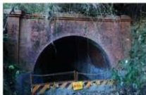
写真2 佐栗谷隧道 [地図:P66] 菊川市高橋字在栗谷と御前崎市新野の境界にある全長93.3mのトンネルで、両端は煉瓦造りですが、中央部は掘り放しです。
