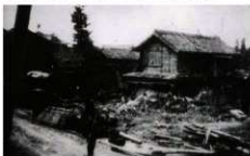
写真5 東南海地震 (写真は平田周辺の被災状況) 小笠郡全体で死者20人・負傷者36人、住家全壊1,154棟・半壊1,407棟、非住家全壊840棟・半壊1,284棟と大きな被害がありました。
