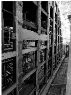
軸組み完了後
