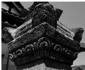
写真26 真浄寺宝篋印塔の屋根（斜め下から）
