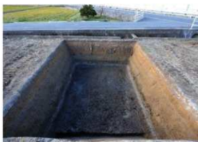
第2遺構面 検出状況(東から)
