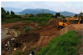
写真45 取水口遠景(6月8日)(北東より)
