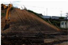
写真49 堤体西側断面(6月27日)(東より)
