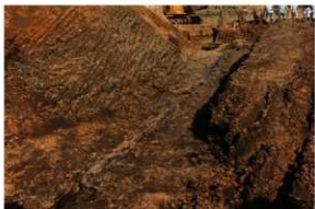
写真47 木樁検出状況(6月15日)(西より)
