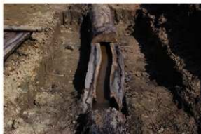
写真48 2本目木樁の北端部(6月15日) (北西より)
