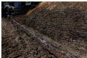
写真46 木樁検出状況(6月15日)(南より)
