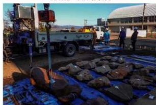
トラッククレーンスケールによる礎重量計測
