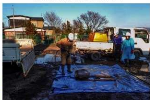
高圧洗浄機による礎洗浄
