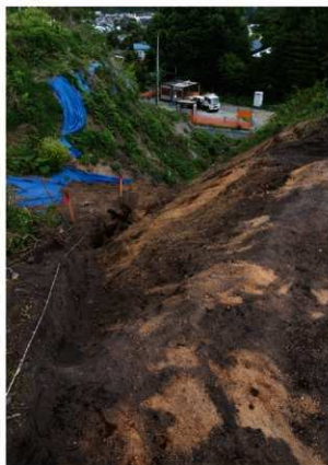
第1号堀跡調査状況（西から）
