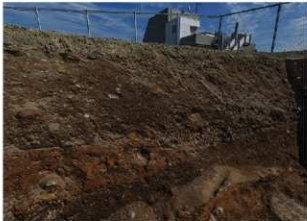
14 トレンチ北壁 (南西から)
