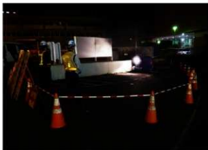
掘削箇所南側 遠景 (南南西から)
