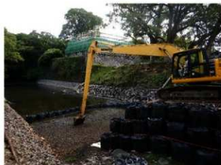
備前堀浚渫作業状況（南西から）
