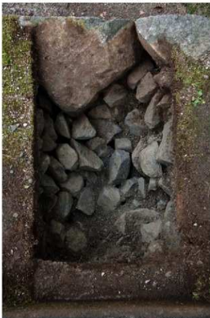
外南 21 トレンチ 栗石背面構造① 検出状況
