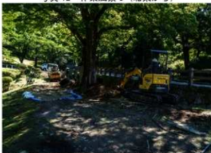
写真 13 作業風景 2 (西から 写真奥が法華坂)
