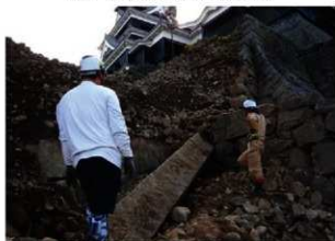
H424-298 崩落石材回収作業状況 (北東から)
