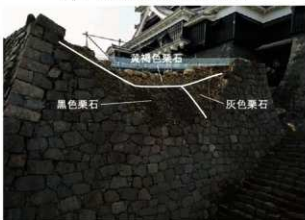
H498 背面構造 (北東から)
