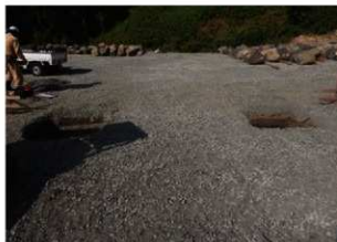
門扉部分掘削完了後（東から）
