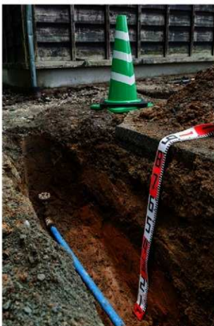
写真 23 土層断面 4 (南東から 奥は公衆トイレ)
