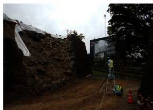
石垣測量作業状況（西から）
