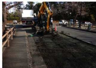
掘削作業状況（南から）
