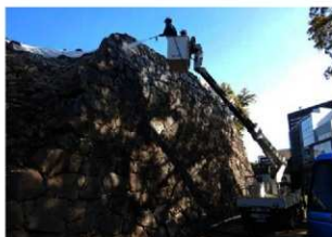
石垣面水洗状況（南西から）
