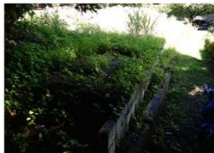
空洞ブロック撤去前（西から）
