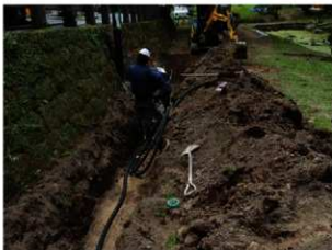
写真 12 作業風景 3 (北東から)
