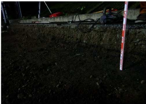
掘削完了後北壁（南東から）
