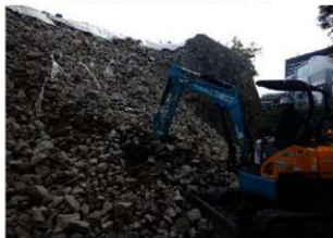
裏込め回収作業（北西から）
