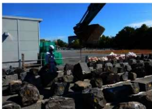
石材仮置き作業状況（西から）
