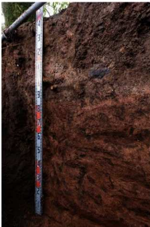
地点③ 南壁 (北から)
