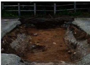
トレンチ11 全景 (西から)
