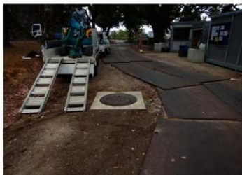
掘削前作業状況（南から）
