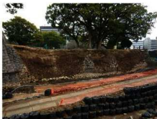
H596・H594 石垣石材回収状況（北西から）
