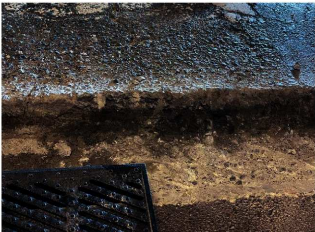
掘削部分北壁断面(南から 断面は全てアスファルト)
