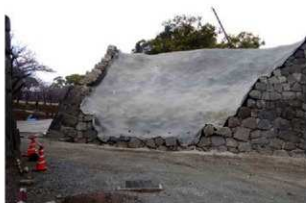
水洗後石垣面モルタル吹き付け状況（南から）
