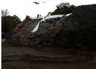
崩落石材回収完了状況（南から）
