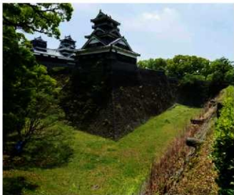
宇土櫓下空堀確認調査前状況（北西から）
