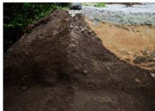
トレンチ3 土層断面 (西壁)
