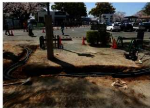
掘削完了後（北から）
