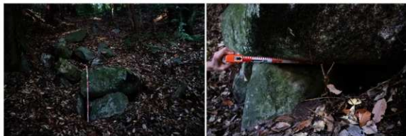
②紅雪堀西側屈曲部の石垣 左：全景、右：石垣断面控え
