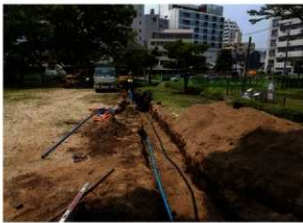
写真5 作業風景（北から）
