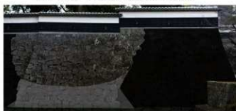
H596・H594 石垣崩落状況（北西から）
