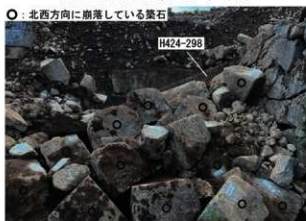
H424 3 層目崩落状況 (北から)
