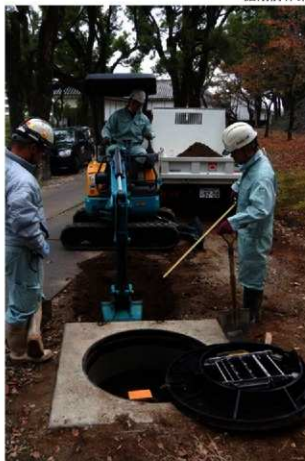
掘削作業状況（北から）
