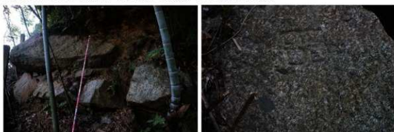
⑫舟入南西部石垣隅角部 左：近景、右：刻印
