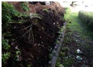
空洞ブロック撤去後（西から）
