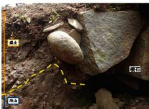
H438・H439 隅角部根石前の地業 (北西から)
