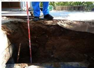
掘削箇所東壁（西から）
