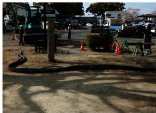
掘削作業前（北から）
