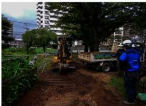
写真7 作業風景（東から）
