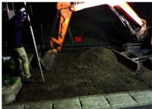
掘削状況（南から）
