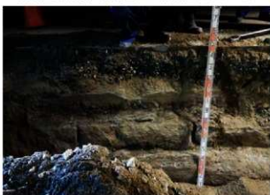
掘削箇所北側 北壁 土層断面 (南東から)
