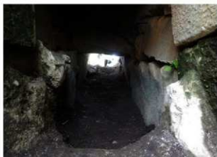
溝④石組及び内部状況（北東から）
