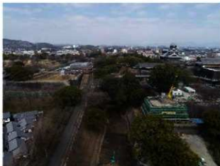
備前堀浚渫作業完了状況（南から）
