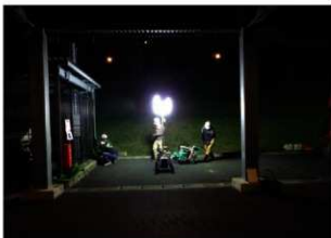
掘削前（南から）
