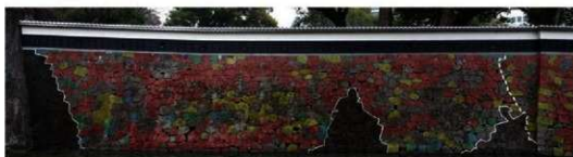
H594（上）、H596（下） 石垣の崩落範囲と原位置、崩落層位の照会結果（西から）
