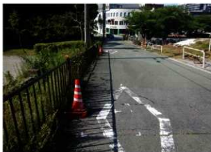
水道引込管閉塞箇所掘削前 (北から 赤色のコーンが掘削予定地)
