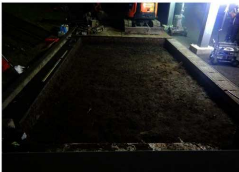
掘削完了状況（西から）
