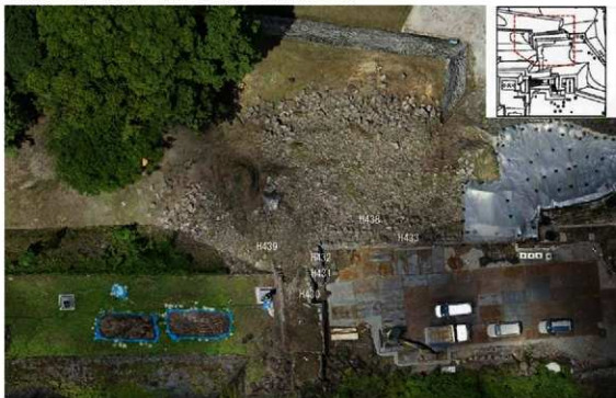
石門北側石垣崩落状況（上が北）
