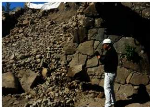
崩落石材回収状況（南から）
