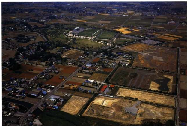
調査区遠景 (南より)
