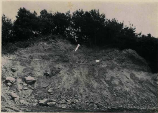
A) 発見当時の工事現場 (矢印が天井開口部)
