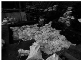
写真124 調査区1 埋め戻し状況①
