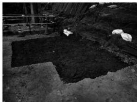
写真126 調査区1 埋め戻し状況③
