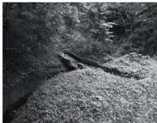
写真4 沢を底樋で横断する水路
