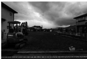
2 調査地全景（北から）
