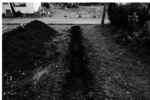
6 Bトレンチ完掘（北から）
