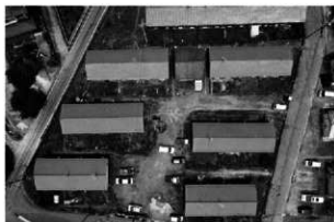
1 調査地全景 (上が北)
