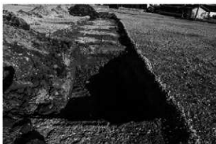
12 B トレンチ全景 (西から)
