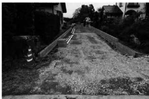
1 調査地全景（南から）
