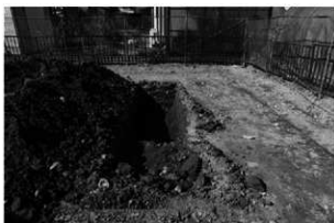
5 A トレンチ完掘 (東から)
