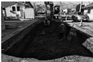
11 F トレンチ全景 (東から)
