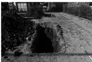
7 B トレンチ完掘 (東から)
