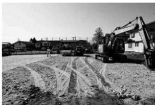
2 調査地全景（北から）
