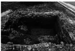
9 C トレンチ完掘 (南から)
