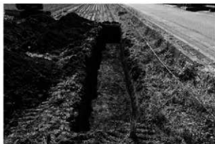
5 トレンチ完掘（南から）
