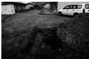
5 Bトレンチ完掘 (西から)
