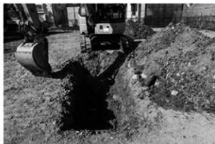
11 Dトレンチ完掘（東から）
