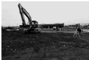
1 調査地全景（南から）
