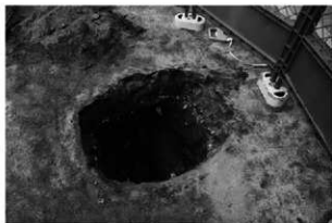
3 A トレンチ完掘 (東から)
