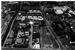
1 調査地全景 (南から)
