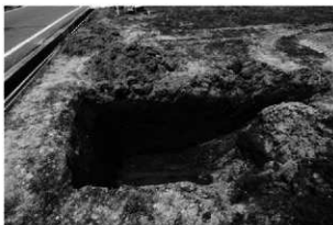
5 A トレンチ完掘 (東から)
