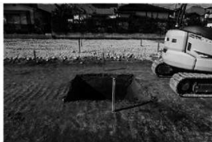
3 トレンチ完掘（東から）
