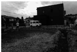
1 工事立会掘削 (北西から)
