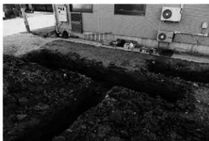
4 Bトレンチ完掘 (北から)
