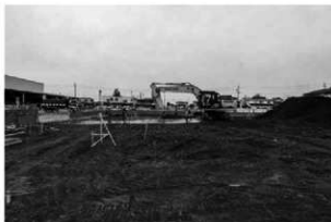
2 調査地全景（北から）
