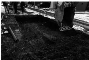
9 E トレンチ全景 (西から)
