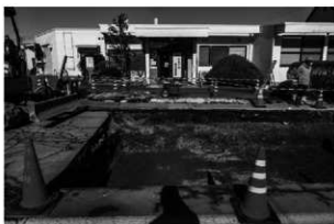
13 G トレンチ全景 (南から)
