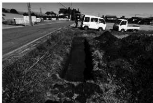
4 トレンチ完掘（南から）
