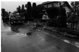
2 トレンチ完掘（南東から）
