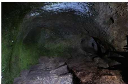
石窟内部状況
