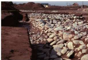
石積堤防 (東から)
