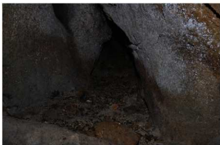
石窟内右側壁から奥へと続く空洞状況
