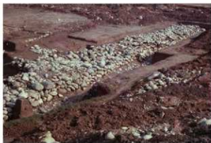
石積堤防 (西から)
