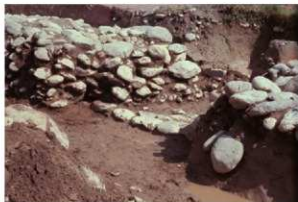
石積堤防基礎部
