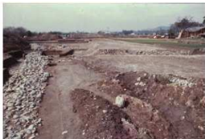
石積堤防・広場・切落し (東から)
