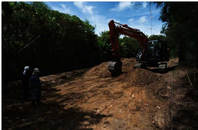
重機掘削作業
