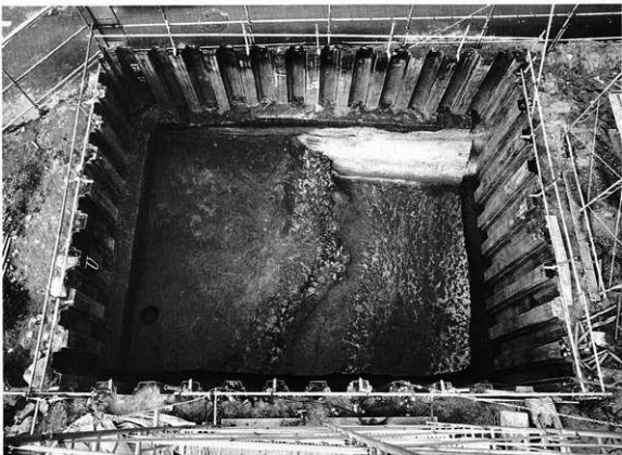
第2地区、第Ⅵ遺構面SD627（南から）
