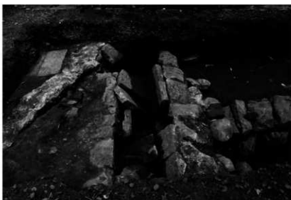
写真13 T-10 001SD 石蓋陥没状況 東から
