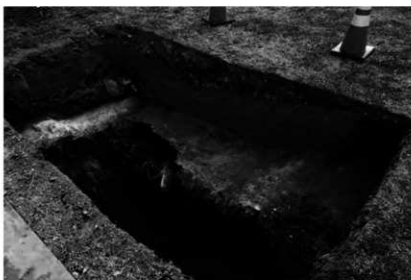
写真10 T-5 完掘 北西から
