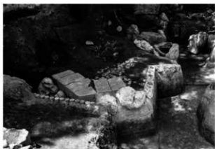
写真24 北園池 東南部掘削状況 東から
