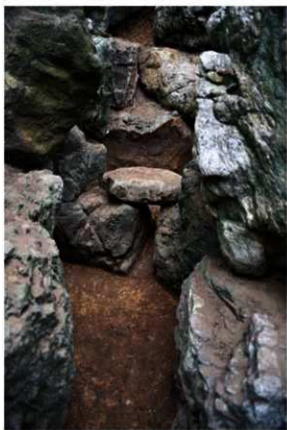
写真6 北園池 滝底部の三和土 南から
