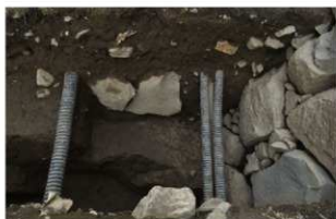
4 石垣裾部状況 (北から)
