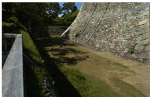
2 調査前状況（内堀西側）（南から）
