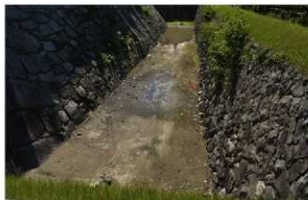
1 調査前状況（内堀北側）（東から）
