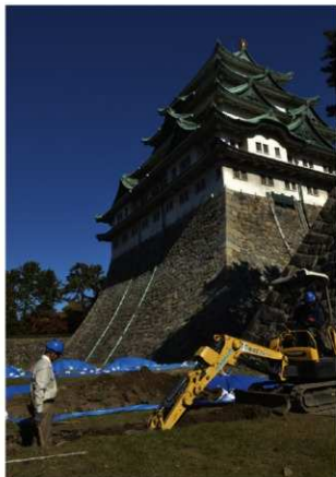
1 V区掘削状況（南西から）
