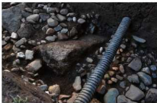
5 W区石列石材 w-4 西端部確認状況（北西から）
