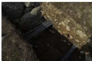
5 T区石垣裾部（南東から）
