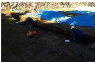
7 U区掘削状況（西から）
