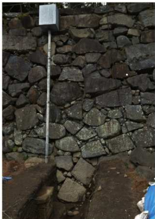
2 S区東側石垣 (東から)
