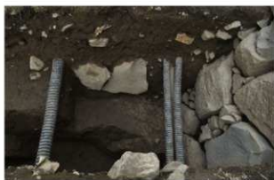
4 石垣裾部状況 (北から)
