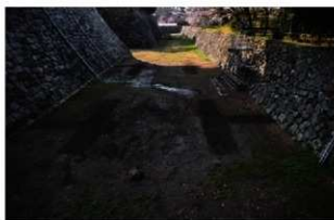
7 埋戻し完了後 (北から)
