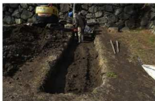
4 S区埋め戻し作業（東から）
