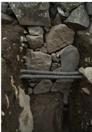
6 石垣裾部状況 (東から)
