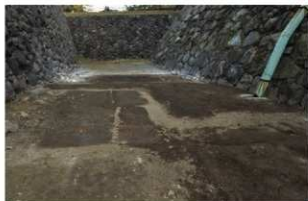
6 R区埋め戻し完了（西から）
