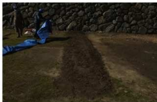
7 V区埋め戻し完了（東から）
