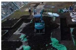
6 埋戻し作業風景 (北から)
