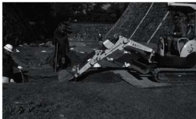
図 17 令和元年度調査風景(南から)
