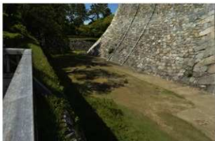
2 調査前状況（内堀西側）（南から）
