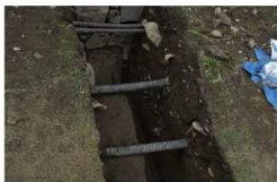
5 石垣直下の状況 (南東から)
