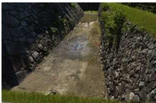
1 調査前状況（内堀北側）（東から）
