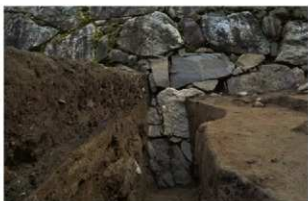
4 R区サブトレンチ完掘（北から）
