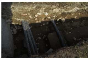
6 T区石垣裾部（南から）
