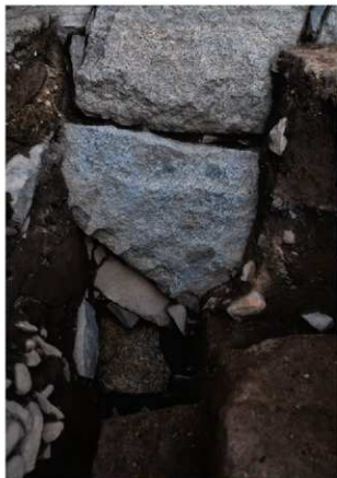
1 Z区大天守台石垣下部確認 (西から)
