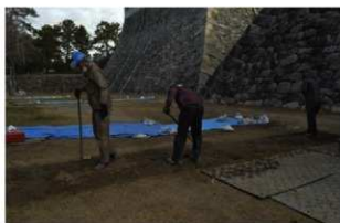
5 V区埋め戻し作業（南から）
