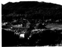
着々と進む圃場整備工事
