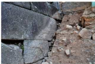
3 調査区3 石垣面検出状況（北西から）
