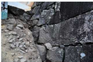
3 調査区6 地表下石垣検出状況（南東から）
