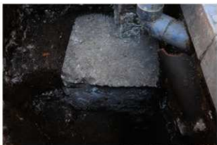
3 調査区1 コンクリート基礎検出状況（北から）
