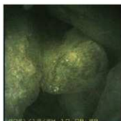
① 深さ 0.3m 円礫が詰まる
