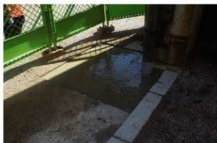
図1-4 アスファルト打設状況
