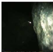
① 深さ 0.35m 円礫が詰まる
