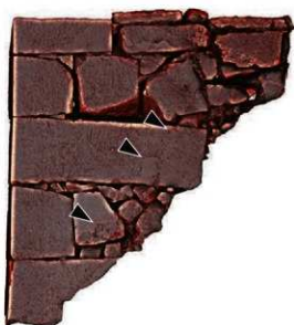
調査区5石垣面可視化処理画像
