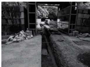
図4-22 表二の門周辺調査状況
