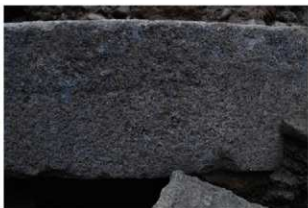
5 調査区6 切石側面検出状況（東から）
