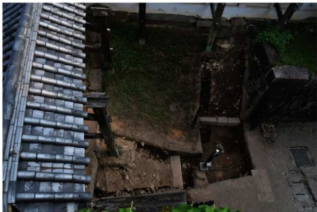
1 第2次調査 調査区3・4完掘状況（北から）
