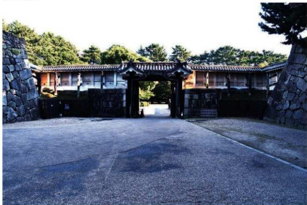
1 重要文化財名古屋城表二の門 第2次調査前状況（北から）
