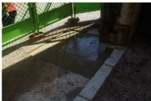
図1-4 アスファルト打設状況
