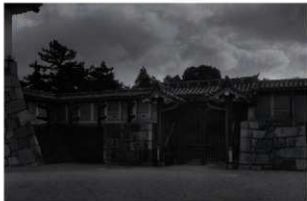
図4-5 ガラス乾板写真1（表二の門背面）
