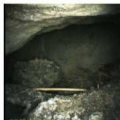
⑪ 深さ 0.5m 円礫と径の小さい礫が詰まる
