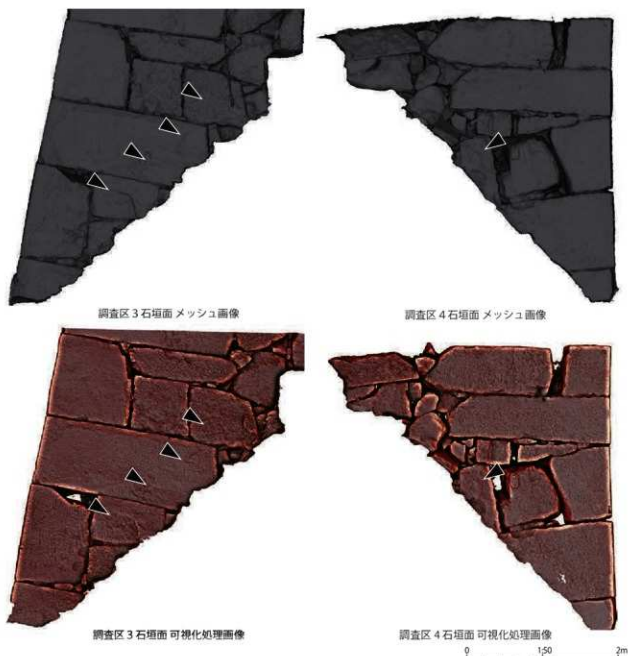
図4-19 調査区3・4石垣面加工痕
