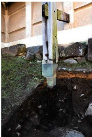
2 調査区2 控柱基部検出状況（北東から）
