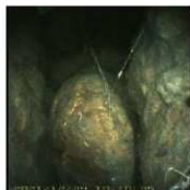
② 深さ 0.25m 石段（左右）間に円礫が詰まる
