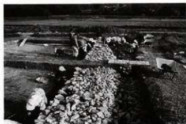
トレンチ掘り込み(平成2年度)
