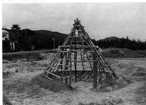
② 骨組みをつくる
