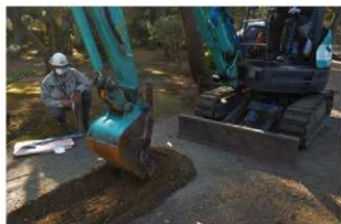
1 E区表土除去状況(西から)
