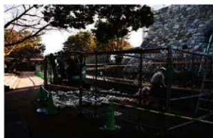
5 C区フェンス設置状況(西から)
