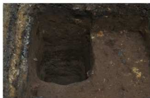
7 N区北西隅テストピット掘削状況（南から）
