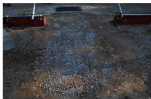
8 B区埋め戻し完了(北から)
