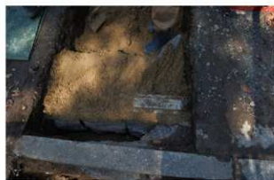
7 B区遺構面養生状況(南から)
