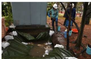
6 E区雨水排出状況(東から)
