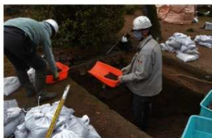
4 G区SK02掘削状況(東から)
