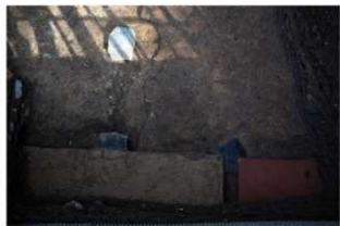
写真11 多春園 三和土下の建物跡礎石列検出状況（三和土東側）
