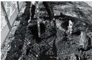
写真40 樹木3伐根完了状況 (東より)
