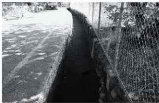
写真4 A1区南側掘削状況（北より）
