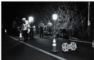
写真66 掘削作業風景（南東より）
