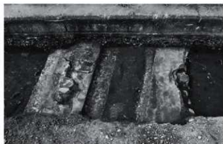
写真77 ⑤ b 区近代建物基礎工検出状況 (東より)
