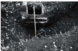
写真37 音楽棟南側中央掘削完了状況 (南より)
