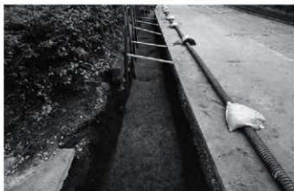
写真6 B3区南側褐色粘質土層検出状況（北より）
