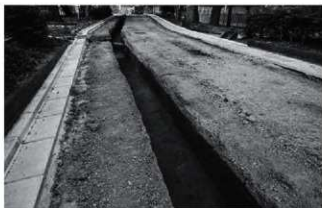
写真5 B6区北側掘削状況（南より）
