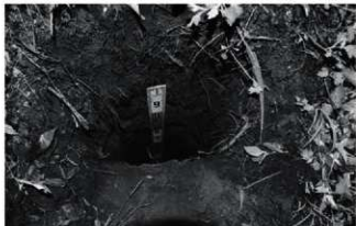
写真67 支線新設箇所の掘削状況（南より）
