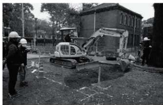
写真62 B2地点北側配線部作業風景（西より）
