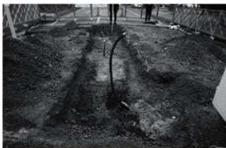
写真45 A1地点基礎部掘削状況 (南より)
