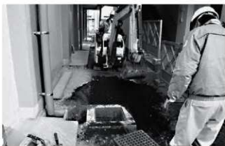
写真54 既設樹撤去状況（南より）
