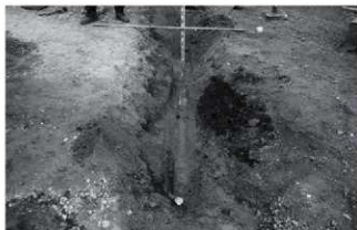
写真48 A2地点南側配線部掘削状況（西より）
