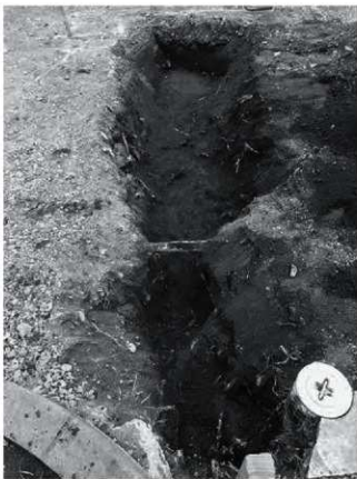
写真65 B2地点南側配線部掘削状況（東より）
