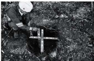
写真69 アンカー設置箇所の掘削完了状況
