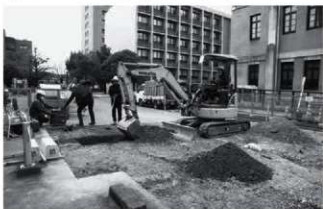
写真60 B1地点南側配線部作業風景 (北東より)
