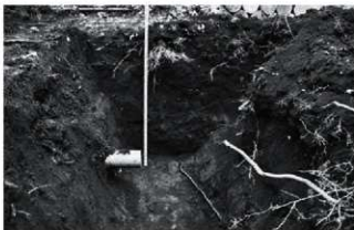
写真38 音楽棟北西側掘削完了状況 (東より)
