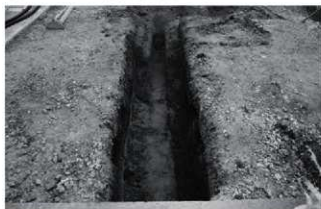
写真42 A1地点北側配線部掘削状況 (西より)
