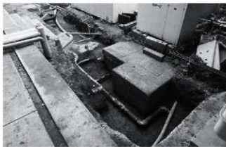
写真7 B5区東側掘削状況（東より）
