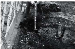
写真39 樹木2伐根完了状況 (東より)
