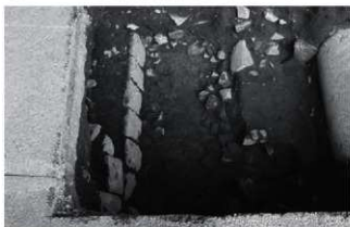
写真26 E3区近代用水路掘削状況（西より）
