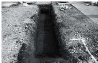
写真61 B1地点南側配線部掘削状況（西より）
