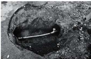
写真80 漏水管修繕完了状況 (南より)
