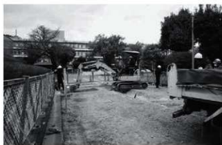
写真41 A1地点作業風景 (南より)
