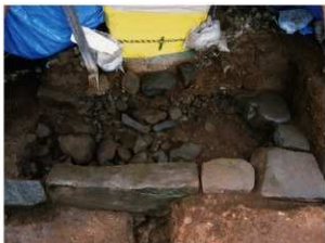
図 3-12 石組基壇 2 層除去後
