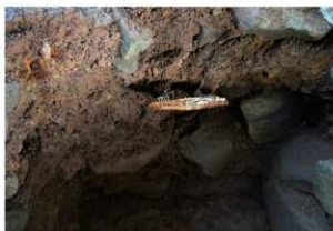
図3-53 西側竿通し金具 (I-11) (西から)
